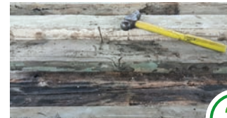
Entfernen von Nägeln, Schrauben und anderen Verbindungselementen
