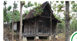
Abriss des Holzhauses
